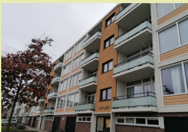
Edificio adaptado en Utrecht.
